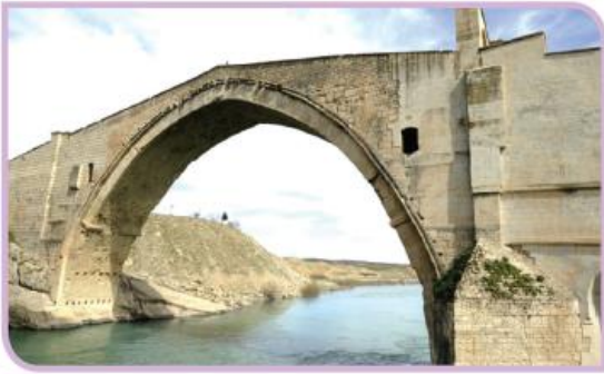
Malabadi Köprüsü (Sivan – Diyarbakır)
